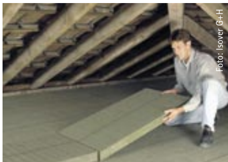
Wärmeverluste auf Dachböden lassen sich durch eine Dämmschicht um bis zu 90 Prozent senken.
