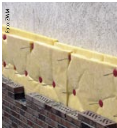
Neue Optik und bessere Dämmung durch eine vor die alte Außenwand gesetzte Klinkerschale.
